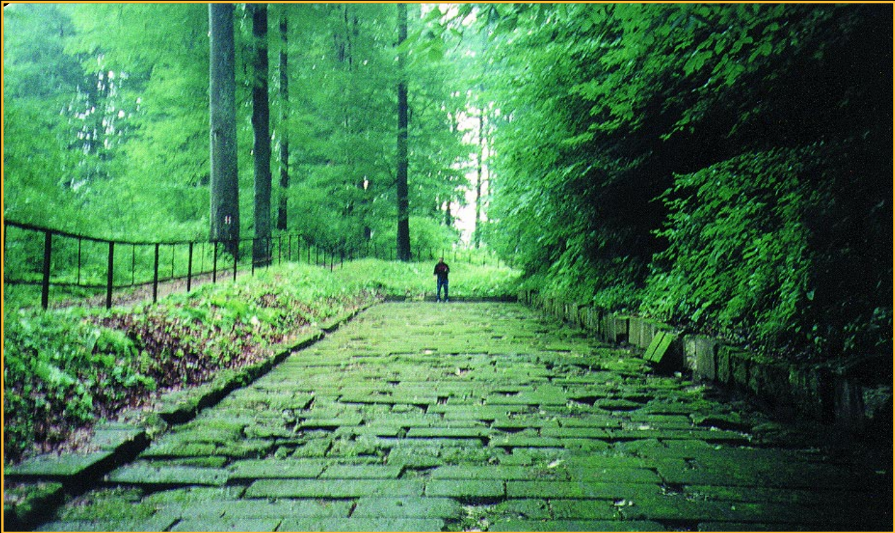
Fig.26. În Țara Zeilor, Daksha, pe Drumul Zeilor, terase construite de daci cu peste 2.000 de ani în urmă, dacă nu și mai mult. O societate de „țărani” capabilă să taie stânci, să construiască ziduri care după mii de ani nu s-au surpat încă, terase din blocuri de andezit pe care trebuiau să le care peste munți și văi de la mari distanțe (70 km. dacă nu și mai mult ), temple ale căror ruine încă mai stăpânesc munții, un adevărat Machu Pichu, aici în munții Transilvaniei, aici la Grădiștea Muncelului și nu numai aici.
